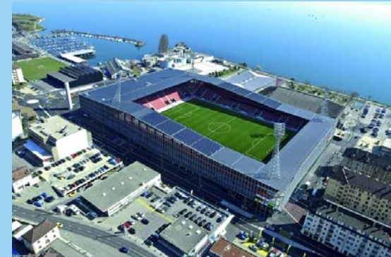
Stadion „La Maladière“ Neuchâtel
